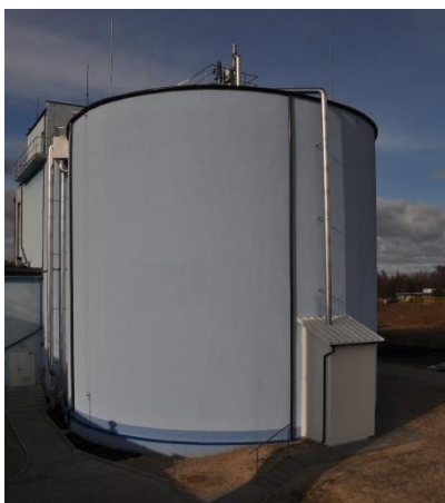
Rysunek 54 Czwarta komora fermentacyjna zamknięta 2 500 m 3
