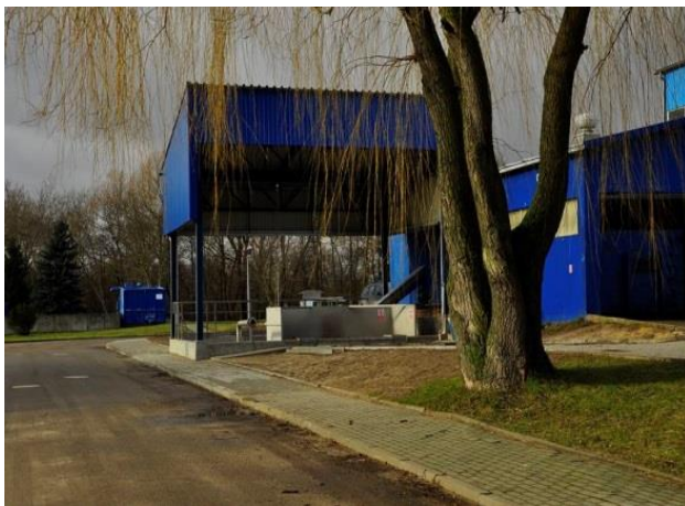
Rysunek 53 Stacja opróżniania wozów asenizacyjnych [SOWA] wstępnego podczyszczenia na nowej instalacji.
