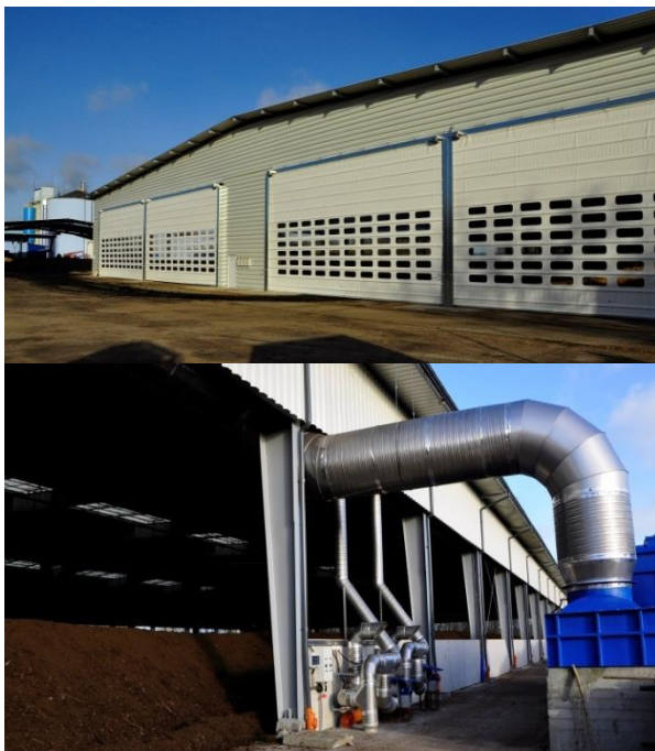
Rysunek 60 Częściowa zabudowa wiaty z systemem wentylacyjnym
