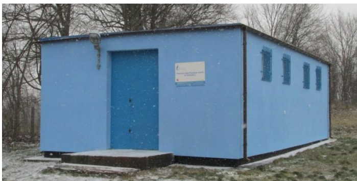
Rysunek 21 Wyremontowana stacja uzdatniania wody we Wrzącej w gminie Kobylnica
