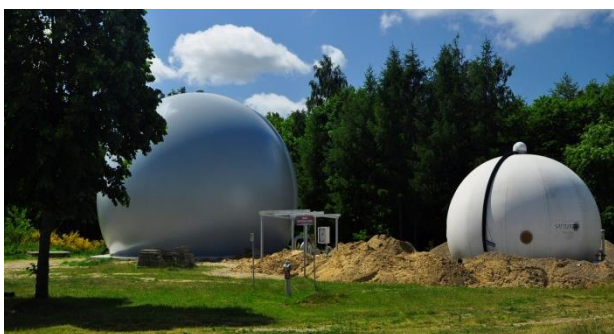
Rysunek 63 Nowy i stary zbiornik biogazu
