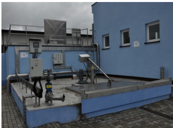
Rysunek 56 Układ do przyjęcia osadów nie wymagających pasteryzacji – zbiornik ZON
