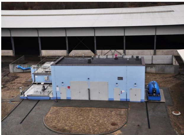
Rysunek 49 Reaktor RBO do usuwania azotu z odcieków
