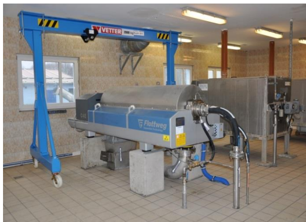
Rysunek 55 Wirówka zagęszczająca osad nadmierny
