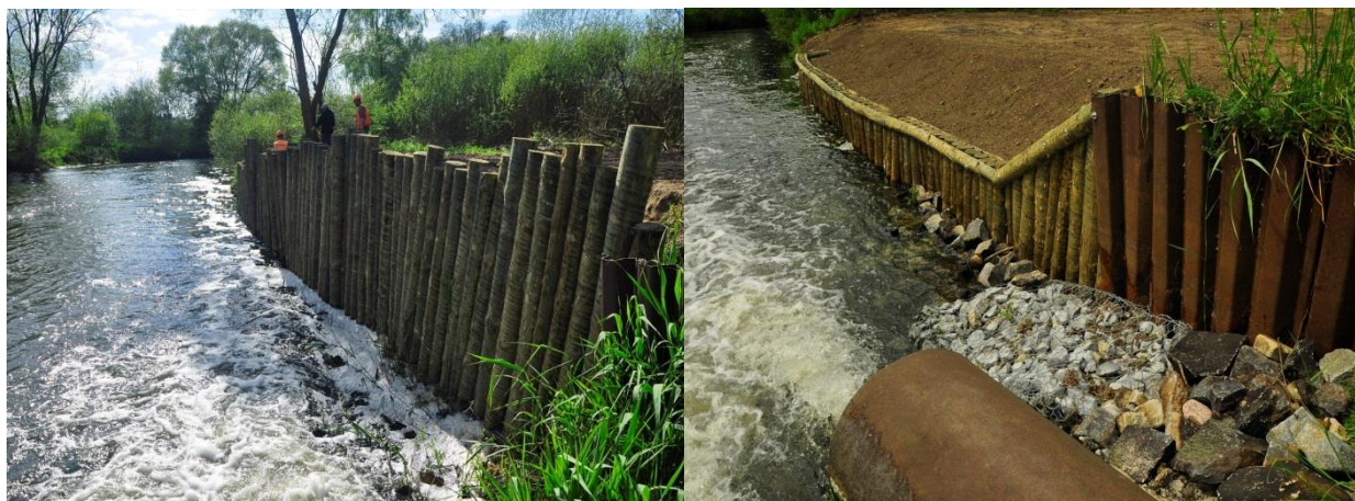
Rysunek 44 Umocnienie brzegu Słupi– wylot ścieków oczyszczonych
