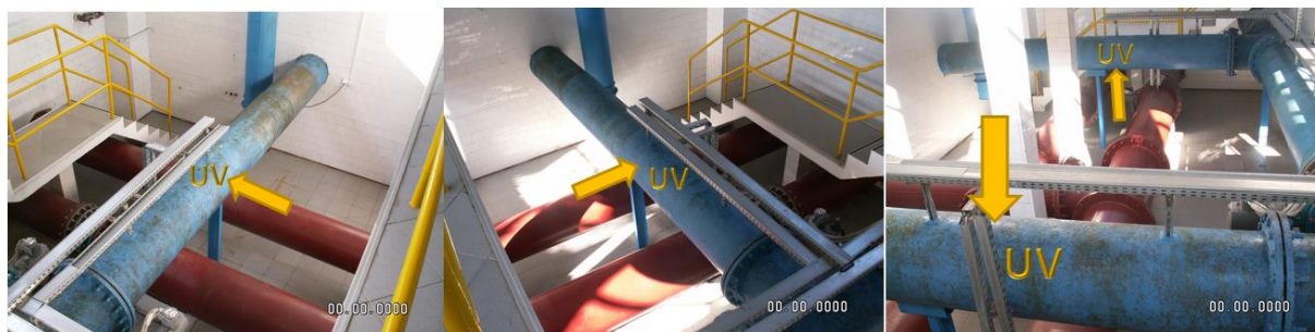
Rysunek 1 Lokalizacja montażu urządzeń do dezynfekcji UV; komora zasuw na SUW w Słupsku
