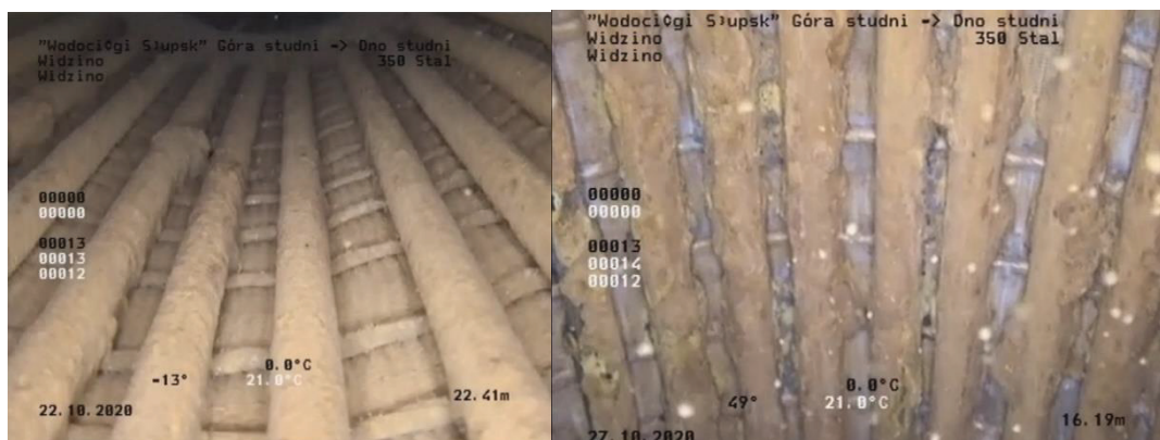
Rysunek 23 Kamerowanie studni głębinowej SW1 w Widzinie (na zdjęciu po prawej widoczna oczyszczona siatka nylonowa otaczająca filtr prętowy; po lewej zdjęcie wykonana przed regeneracją).
