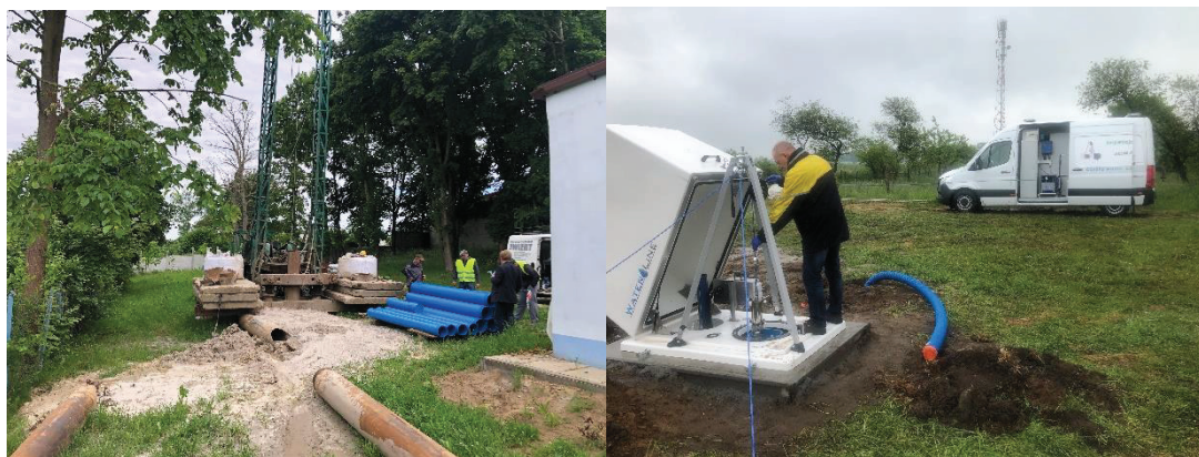
Rysunek 22 Wiercenie studni głębinowej na terenie ujęcia wody w Płaszewie (po lewej stronie) oraz kontrolne kamerowanie nowej studni głębinowej na terenie ujęcia wody w Kczewie.
