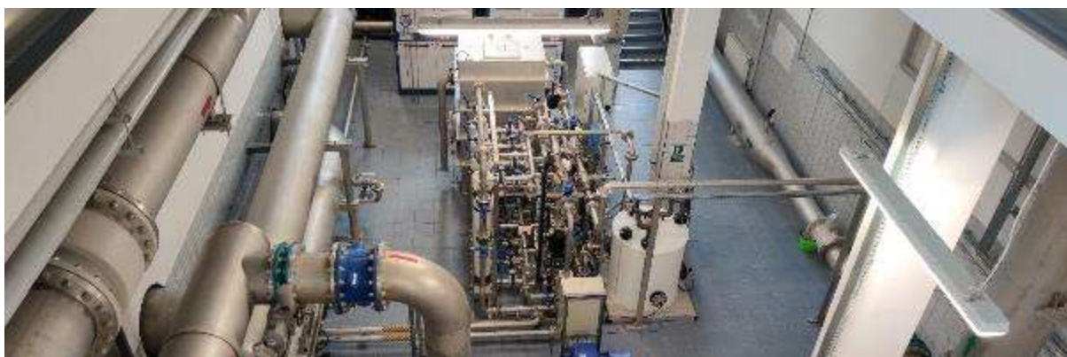
Rysunek 20 Instalacja do ultrafiltracji wód popłucznych
