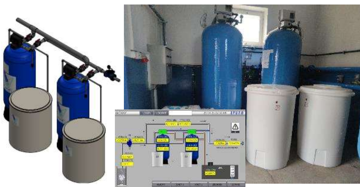
Rysunek 24 Instalacja do usuwania azotanów w drodze selektywnej wymiany jonowej w stacji wodociągowej w Luleminie
