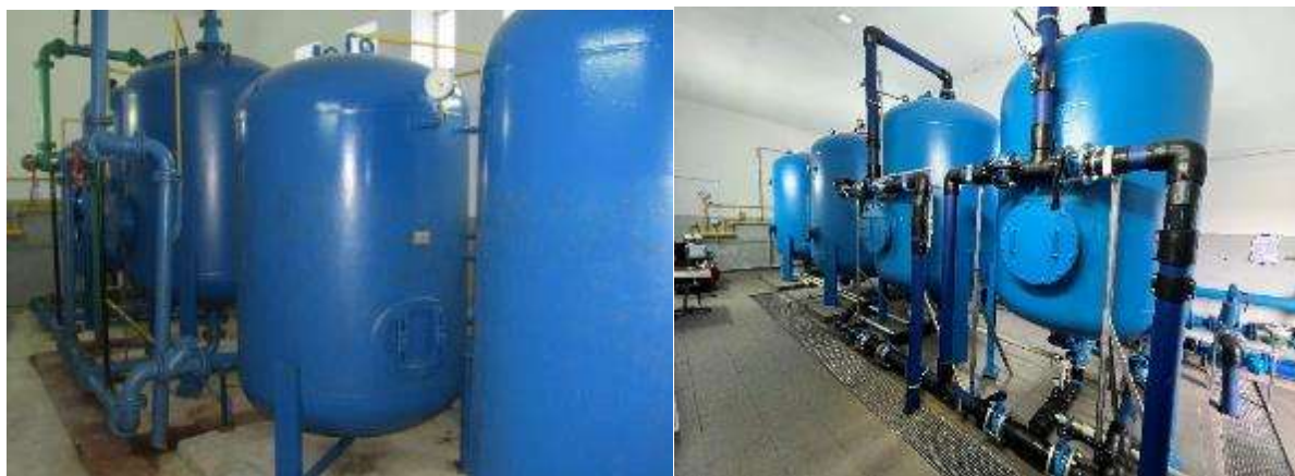
Rysunek 25 SUW w Kończewie przed (po lewej) i w trakcie modernizacji (po prawej)
