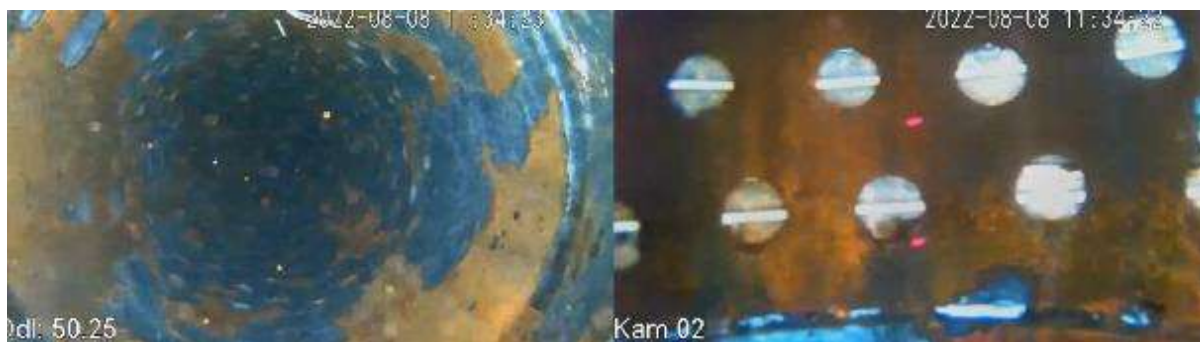
Rysunek 15 Regeneracja studni głębinowej H16 oraz H6 na ujęciu wody Głębino
