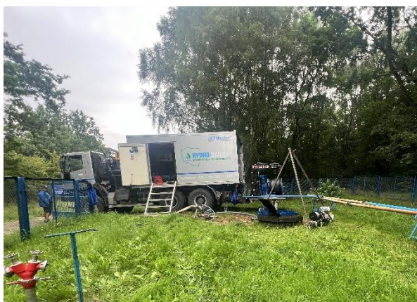
Rysunek 15 Regeneracja studni głębinowej 13b oraz pomiar wydajności studni po regeneracji
